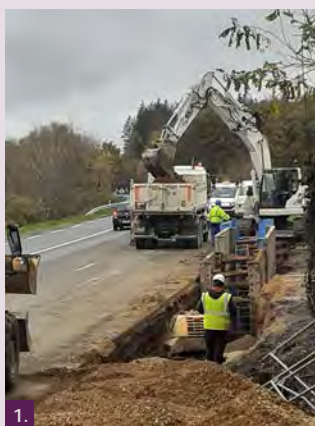
1. Le réseau se situe à plus de 4m sous terre, ce qui a nécessité la pose d'un dispositif de blindage le long des parois de la tranchée de travail.
